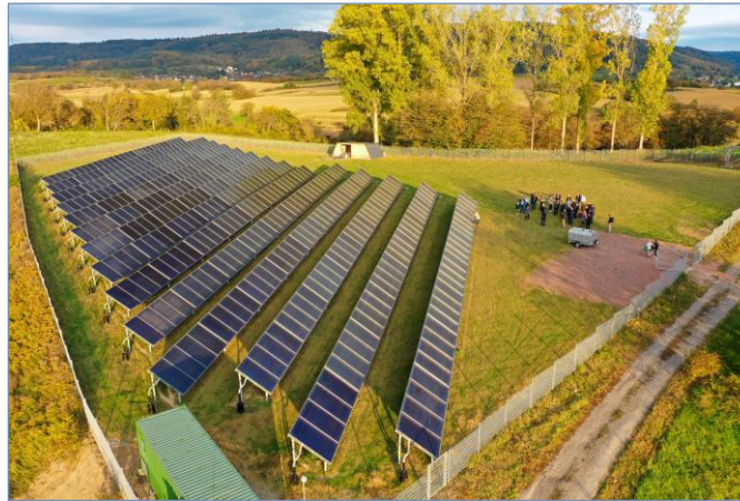
Fernwärme Ettenheim Source: Peter Blaser
