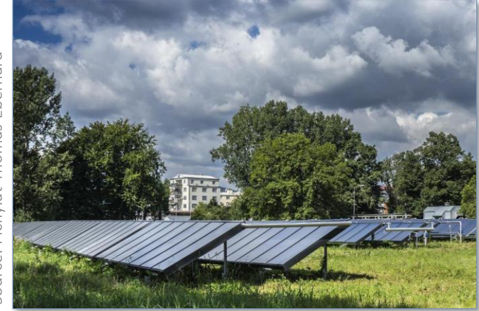
Fernheizwerk Graz (FHW) Source: Picfly.at Thomas Eberhard
